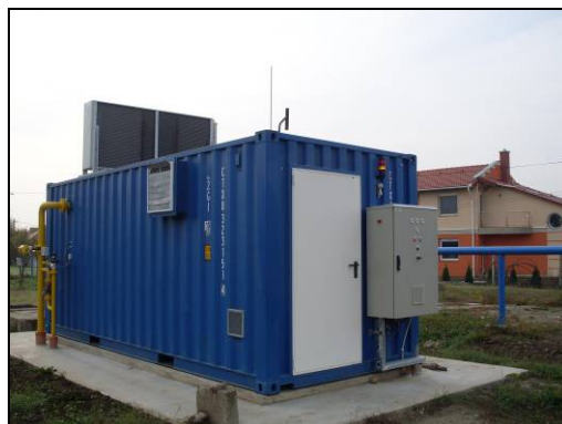
3-6. ábra: Gázgyűjtő- és előkészítő rendszer konténere
