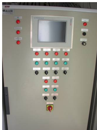
5-3. ábra: Központi felügyeleti rendszer folyamatirányító számítógépe (PLC) - Hajdúszoboszló
